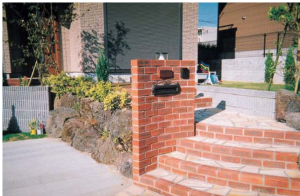
門から玄関へのアプローチを施工
